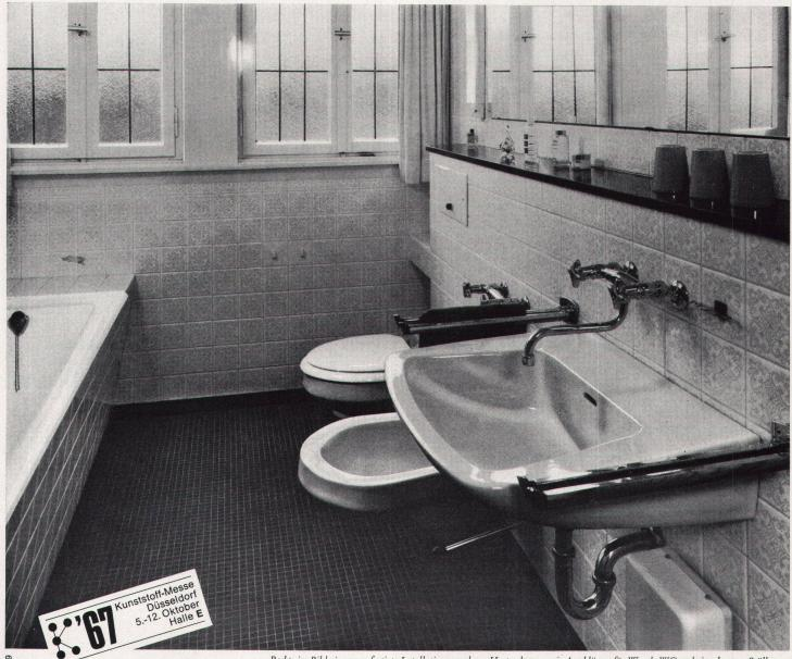
Rechts im Bild eine vorgesertigte Installationswand aus Hartmoltopren mit Anschlüssen für Wand-WC und eingebautem Spülkasten. Ideal für die Modernisierung von Altbauten.
