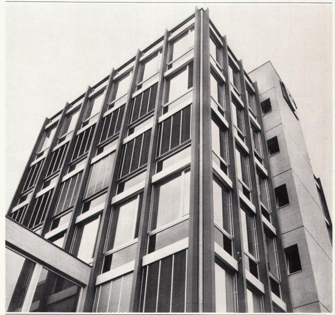
Verwaltungsgebäude K. Rütschi AG, Brugg Vollisolierte Leichtmetallfenster ALSEC mit Isolierverglasung Carl Froelich, dipl. Arch. SIA und Hannes Froelich, Architekt, Brugg
