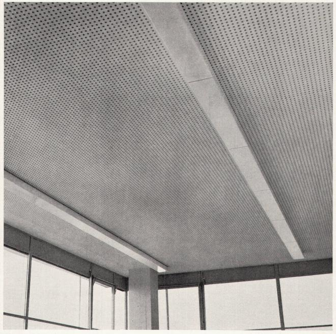
Fugenlose Schallschluckdecke aus Gitro-Platten
