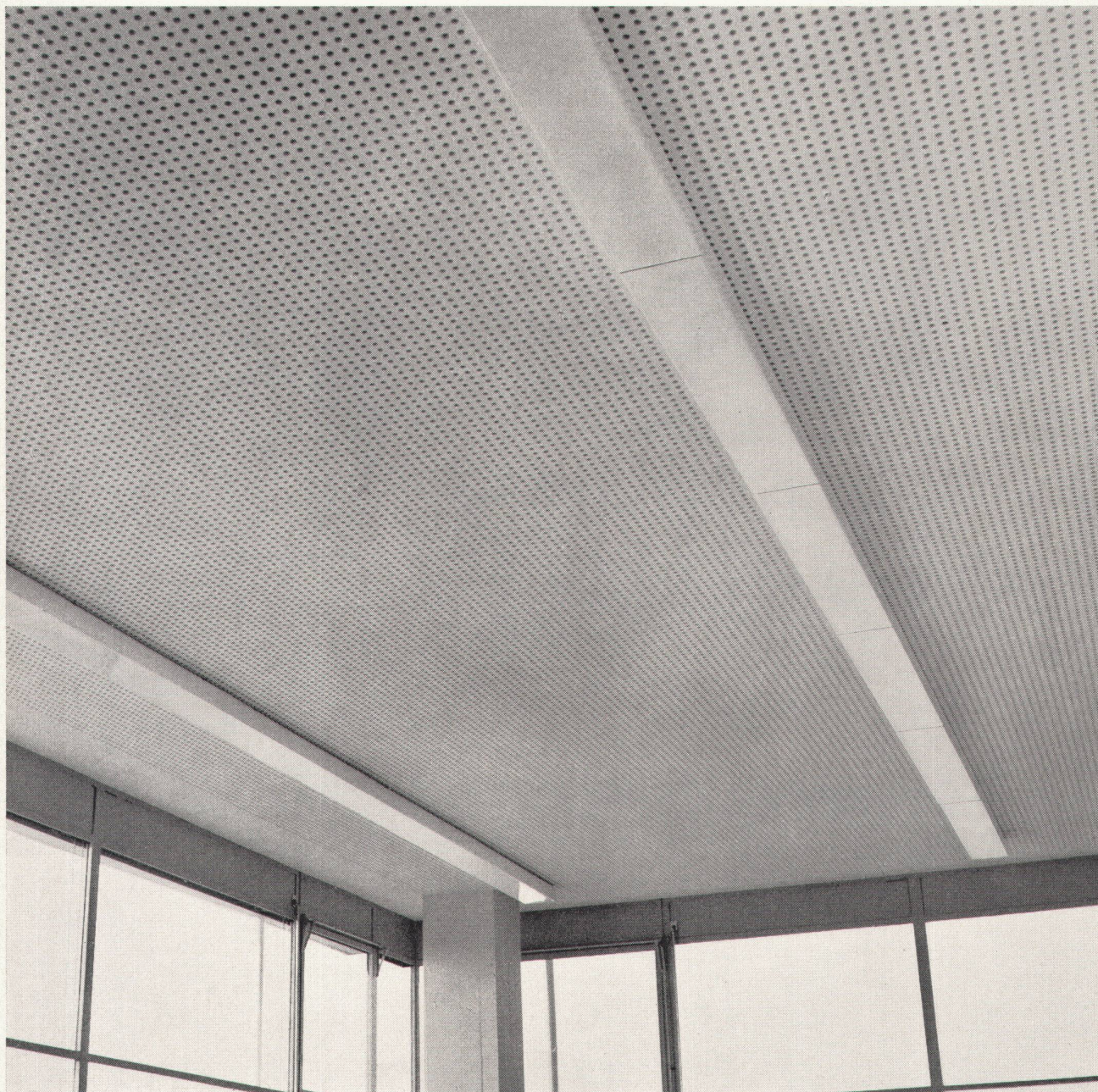
Fugenlose Schallschluckdecke aus Gitro-Platten
