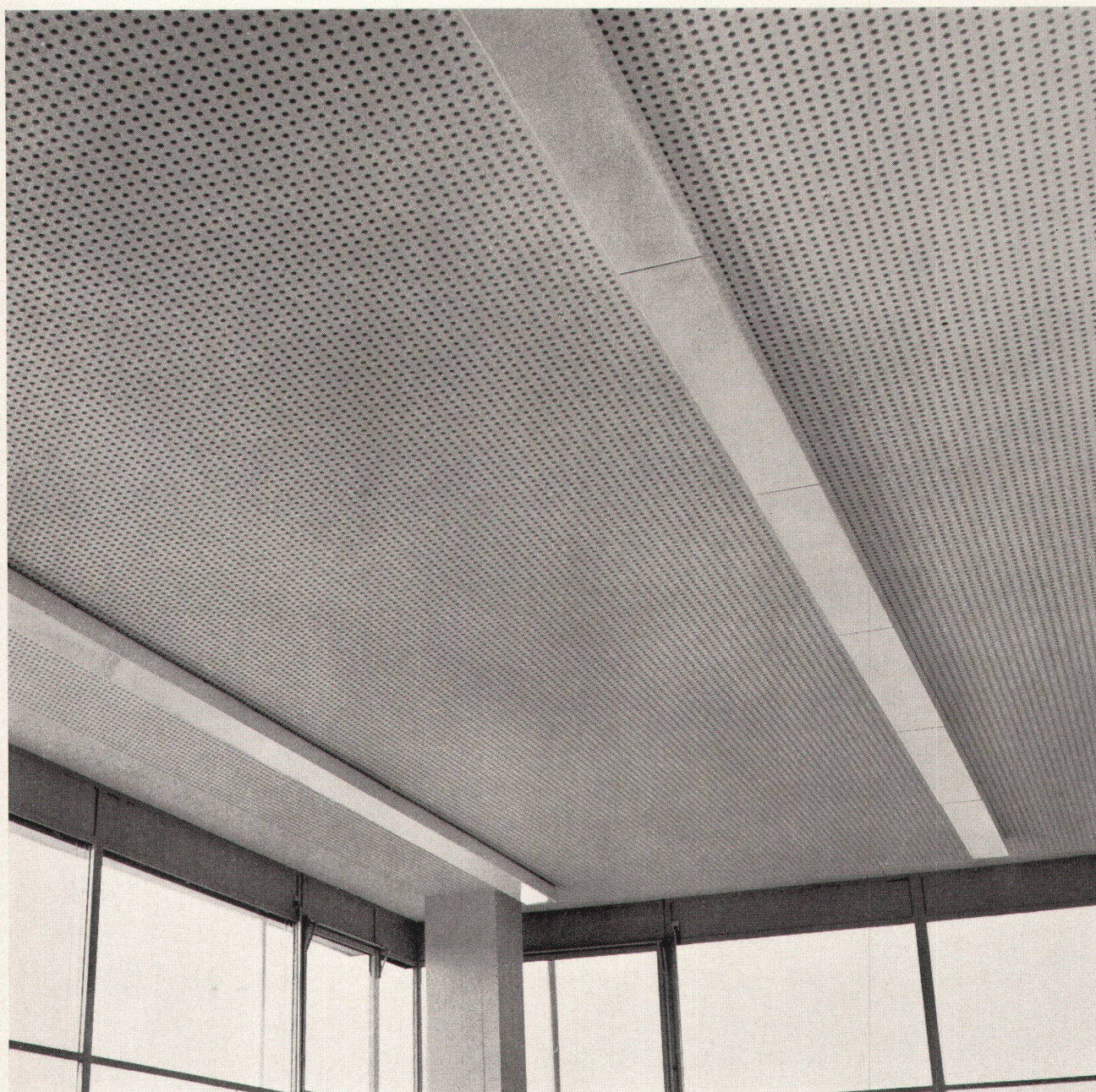
Fugenlose Schallschluckdecke aus Gitro-Platten
