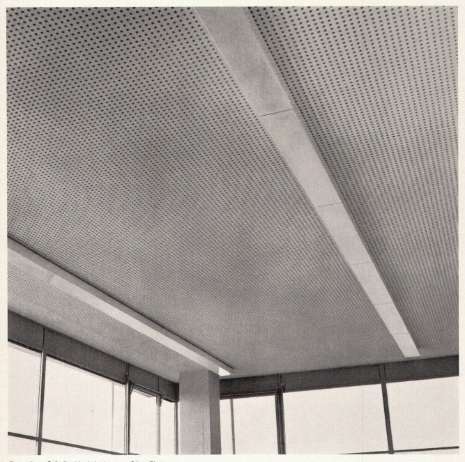
Fugenlose Schallschluckdecke aus Gitro-Platter
