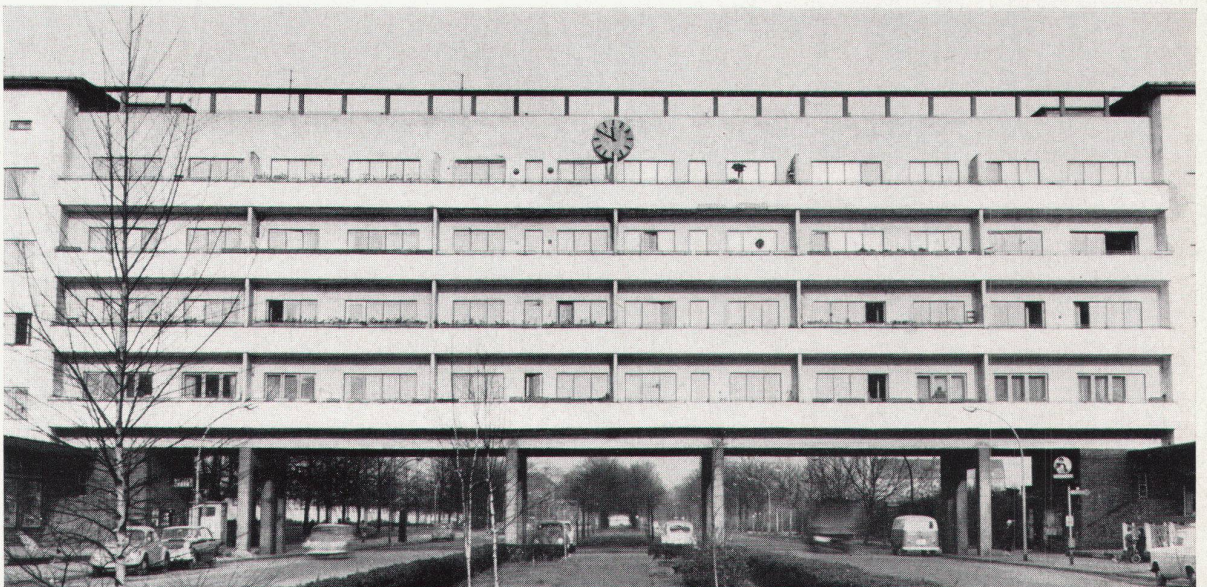
57 Großsiedlung Reinickendorf, 1929/30. Rückseite des Laubenganghauses. Architekt: Otto Salvisberg Lotissement Reinickendorf; face arrière de la maison à galeries Reinickendorf colony. Rear view of portico house
