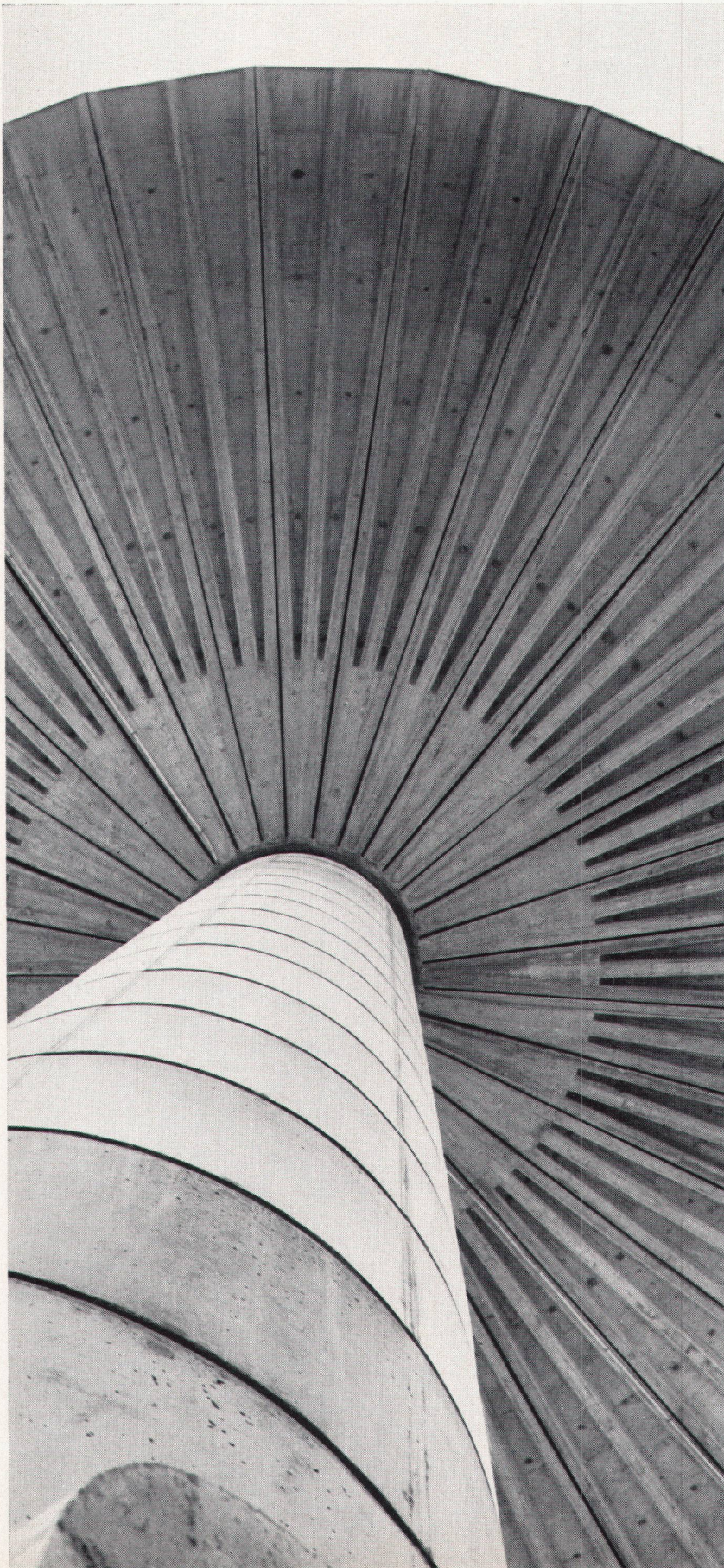
1 Modell des Wasserturms aus vorgefertigtem Beton Maquette du château d'eau en béton préfabriqué Detail of precast concrete water tower
