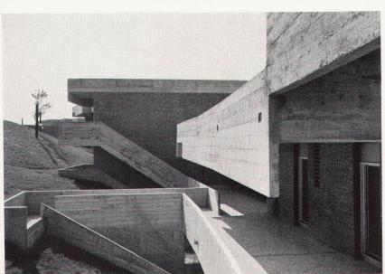
Die Zellen sind aufgebaut auf einem modularen Raster von 90 cm und um 13° konvergierend, um sich den Kurven des Hügels anzupassen. Dieses zweigeschossige Element kann horizontal und vertikal verschoben werden
