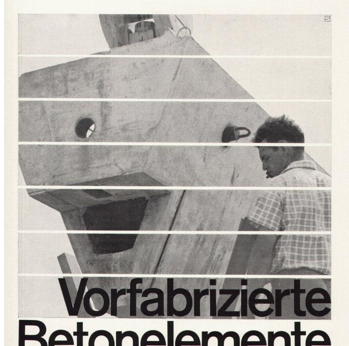
Wirfabrizieren und montieren: schlaff armiert und Träger für Brücken und Hochbauten, Hallenbinder, Stützen, Pfetten, Verkleidungsplatten etc,
