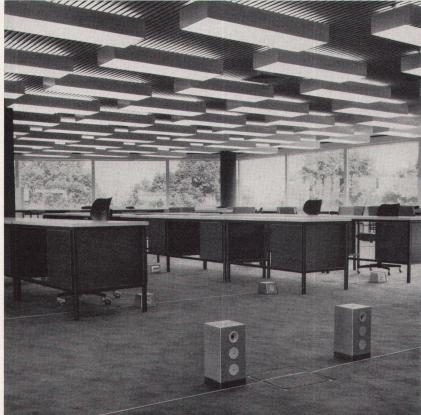
Teli-Flur, das Elektro-Installationssystem in Fußboden und Fensterbankkanal, ist der Träger aller Leitungswege für Starkund Schwachstrom. Der Teli-Flur-Kanal kann auch Jahre Auf Wunsch senden wir Ihnen nach dem Einbau an jedem beliebigen Punkt angebohrt und das Katalog. Verteilsystem dadurch ergänzt oder geändert werden, weshalb eine weitgehende Flexibilität in der Raumnutzung gewährleistet ist.
