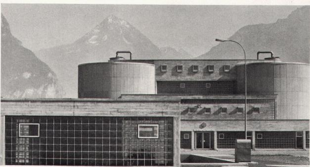
Glasbausteine sind kristallhell, isolierend, hygienisch, dauerhaft, dekorativ, säurefest und korrosionsbeständig. Die wärmeisolierende Wirkung des Hohlraumes verhindert jede Kondensbildung.
