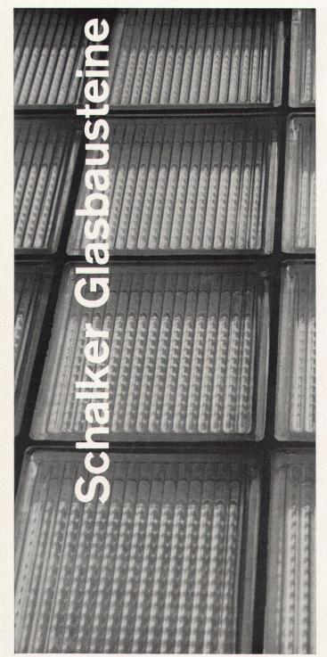
Lichtdurchlässig, isolierend, schalldämmend, hygienisch, wetterbeständig, lange Lebensdauer. — Wir versetzen mit eigenen, speziell geschulten Fachkräften.
