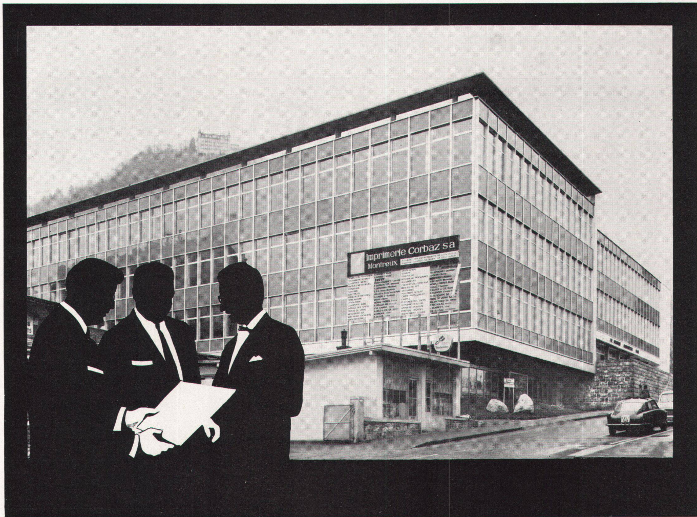
Imprimerie Corbaz SA, Montreux: Lufttechnische Spezialanlagen in der Druckerei und im Papierlager
