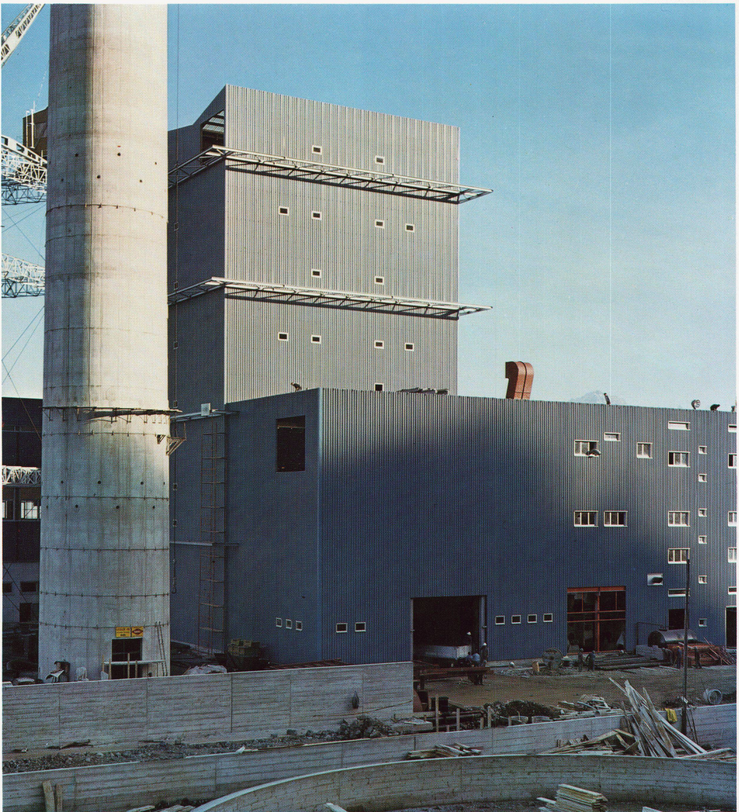
Thermische Kraftzentrale Vouvry mit gewellten Alucolux-Bändern verkleidet
