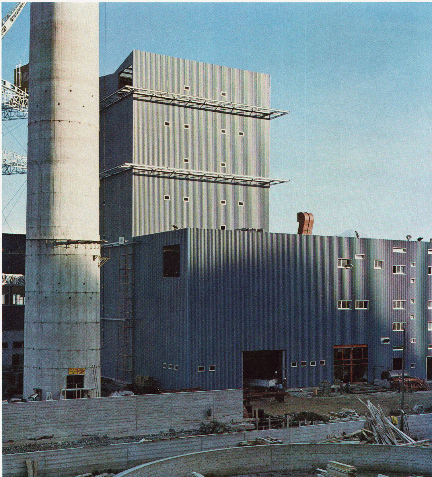
Thermische Kraftzentrale Vouvry mit gewellten Alucolux-Bändern verkleidet
