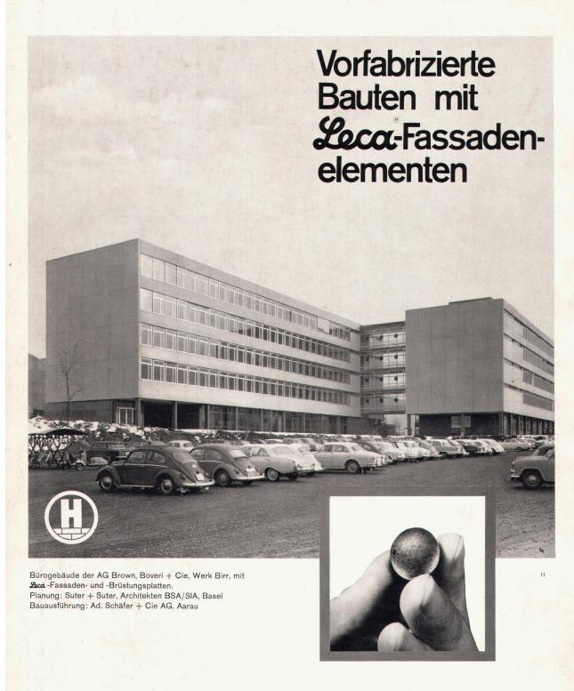
£ $\infty$  eignet sich hervorragend als Zuschlagsstoff für vorfabrizierte Wandelemente, die mit einer Stärke von normalerweise 10 bis 18 cm, in Abmessungen bis zu 8 m Länge und 2 m Breite hergestellt werden. Die thermischen Eigenschaften werden durch eine Wärmeleitzahl  $\lambda$  von 0,2-0,25 kcal/mh°C charakterisiert.
