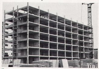
construction industrielle le procédé utilisé dans diverses régions du pays, entre autres à Varsovie, qui fait appel à des éléments d'ossature en béton en forme de lettre H, d'où le nom de portiques en H. Dans ce genre de construction le béton cellulaire est le matériau de prédilection en ce qui concerne les murs, surtout les murs extérieurs.
