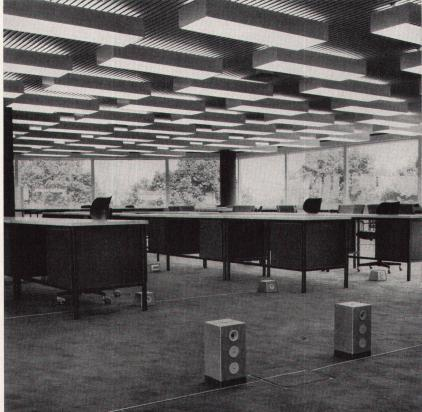
Teli-Flur, das Elektro-Installationssystem in Fußboden und
