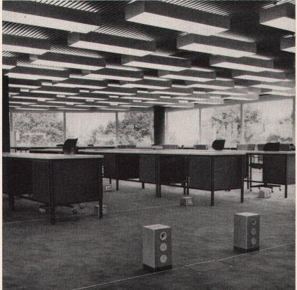
Teli-Flur, das Elektro-Installationssystem in Fußboden und
