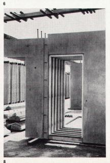
5 Ein Bauelement, genannt «Bauherz», das Bad, WC, Heizung und Küche umfaßt, der Firma Skånska Cementgjuteriet Un élément d'assemblage, dit «le cœur de la construction», comprenant la salle de bains, le W.-C., le chauffage et la cuisine, fabriqué par les usines Skånska Cementgjuteriet Structural element called 'heart of the building', comprising bathroom, toilet, heating and kitchen, manufactured by the Skånska Cementgjuteriet Company
