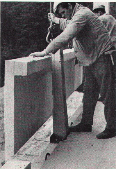
17 Montage eines Brüstungselementes Montage d'un élément de parapet Mounting of a parapet element
