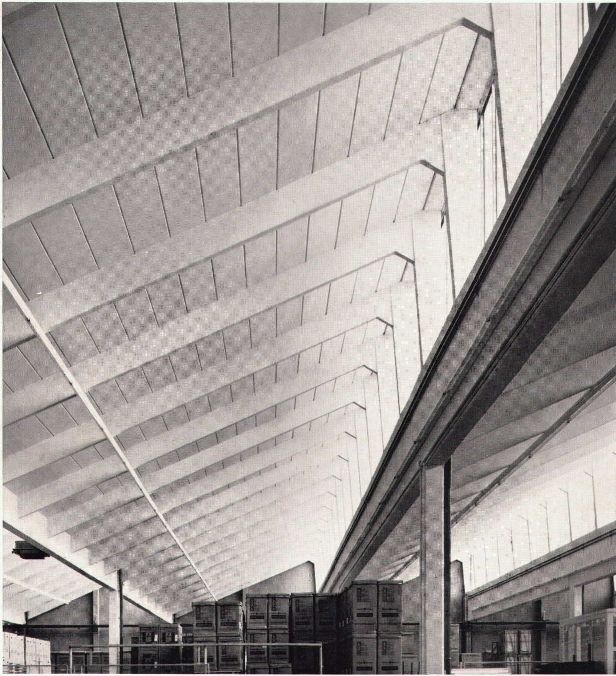
Shed-Dach im Neubau Novelectric Buchs ZH Generalunternehmung Mobag Zürich
