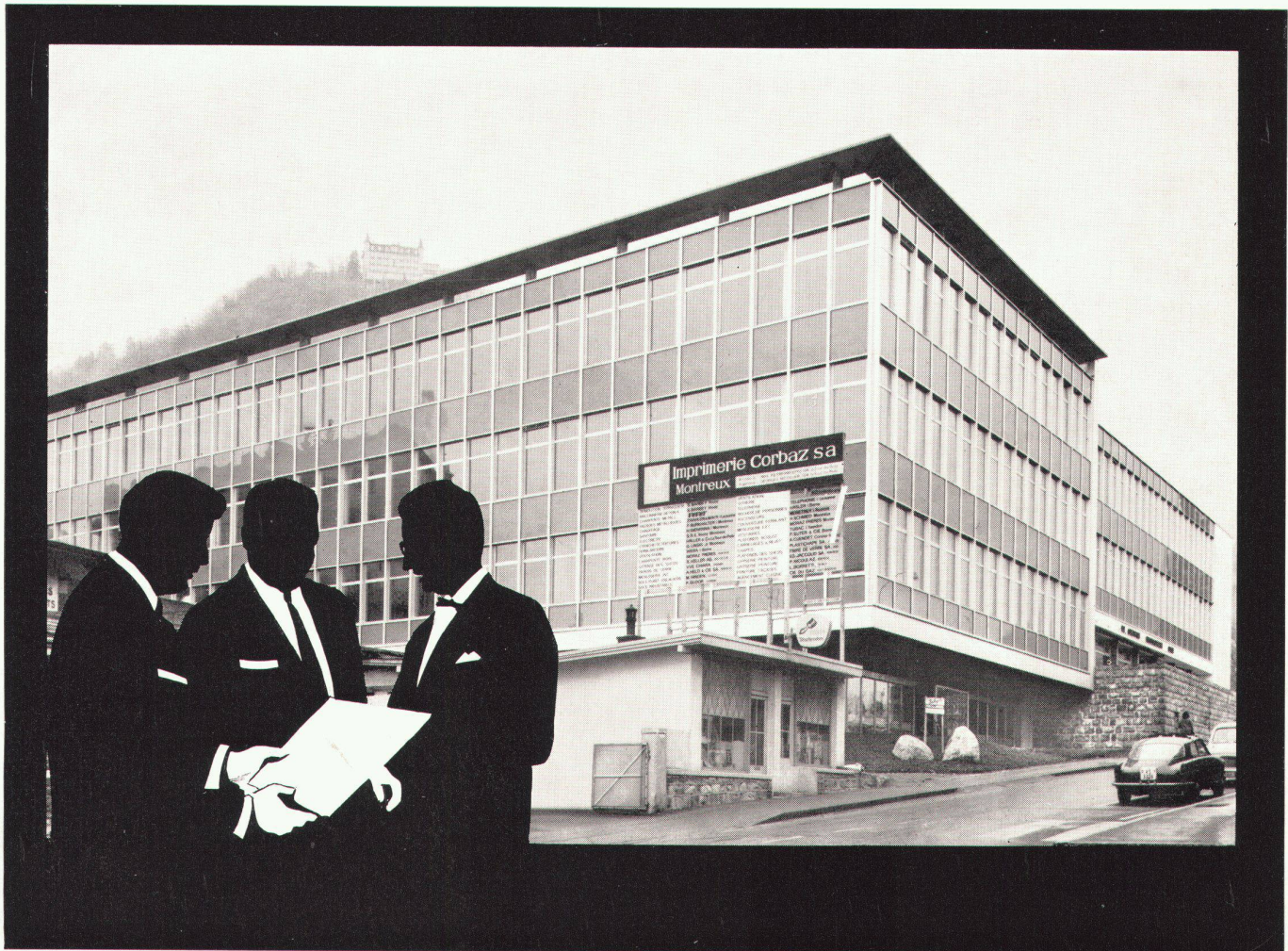
Imprimerie Corbaz SA, Montreux: Lufttechnische Spezialanlagen in der Druckerei und im Papierlager
