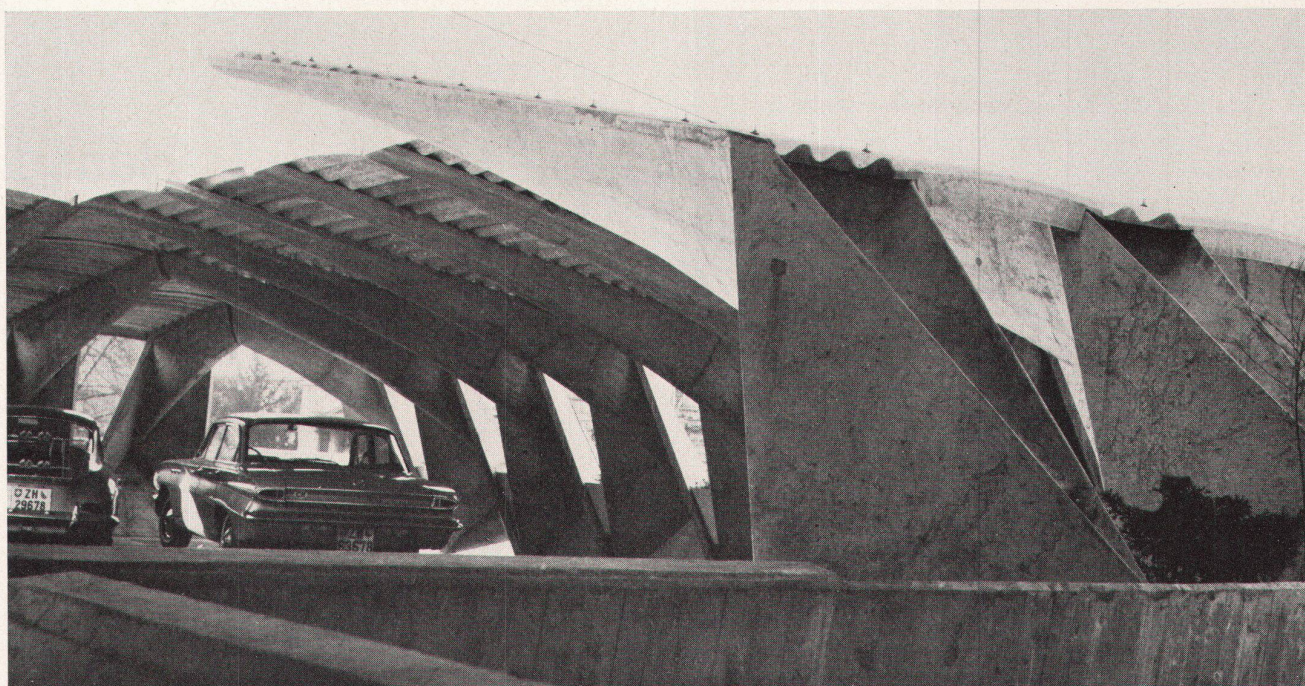
Vorfabrizierte Trägerelemente für das Parkingdach
