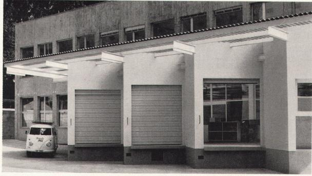
Unser Sectionaltor an einer Verladerampe. Der Öffnungsund Schließvorgang verläuft bei dieser Torkonstruktion in der Senkrechten der Öffnung. Dadurch größte Raumausnützung ohne Behinderung parkierter Fahrzeuge. Erhöhte Sicherheit bei automatischer Betätigung (Einstellhallen).
