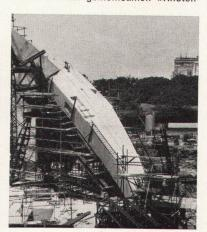
punkt» an der Basis der Seitendächer haben. Dadurch, daß alle Dachteile ähnlich und aus einer Kugelfläche geschnitten sind, wurde in das Schema eine geometrische Disziplin eingeführt, die, wie schon erwähnt, das Aussehen des Bauwerkes wesentlich beeinflußt hat.
