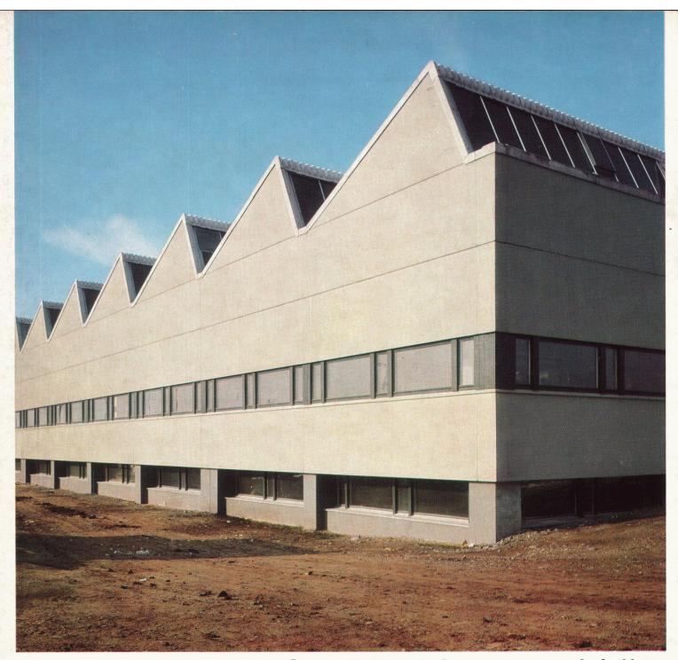
Grossformat-Aussenwandplatten bis zu 9.00 Meter Länge und 2.00 Meter Höhe
