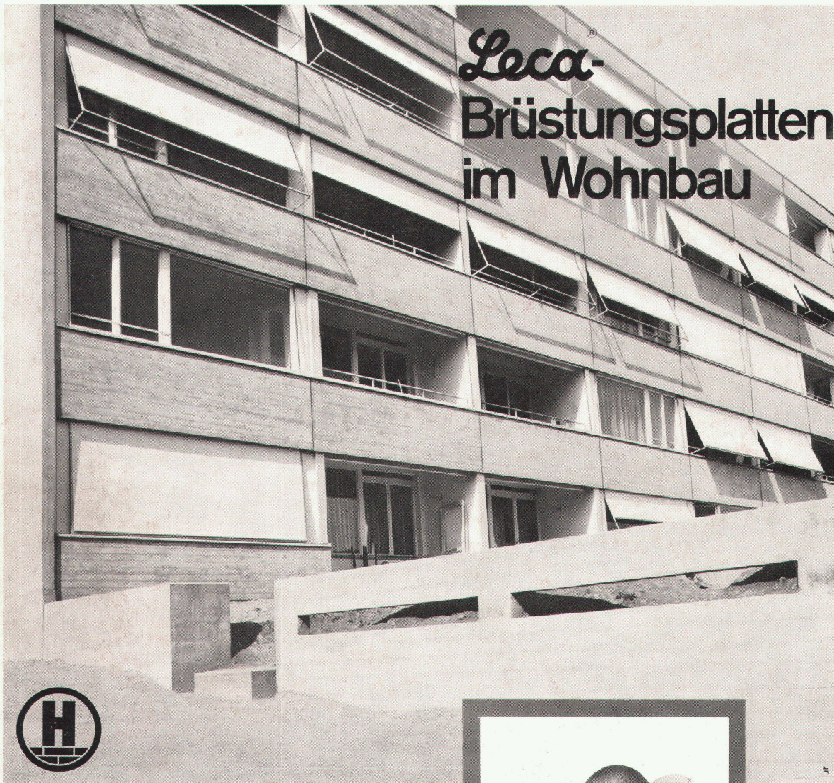
Leca-Brüstungsplatten an einem Wohnhaus der Abag AG in Olten im Format 3,90 x 1,60 m Architekt: W. Fust, Olten Bauunternehmer: Arnet + Co. AG, Olten
