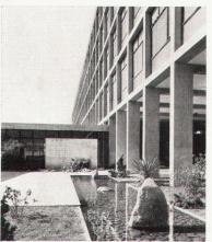
strukturellem Ausdruck. Alle verwendeten Werkstoffe wie Stahl in den Stützen, auf der Baustelle vorgeformter Beton für die Bedachung und Aluminium für die Fenster und Türen, wurden in ihrem ursprünglichen Zustand mit ihrer eigenen Farbe und Textur gelassen.
