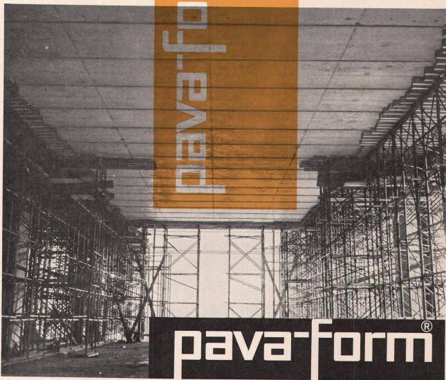
Mit Pava-form Platten vorfabrizierte Betonelemente decken diesen Lagerraum.
