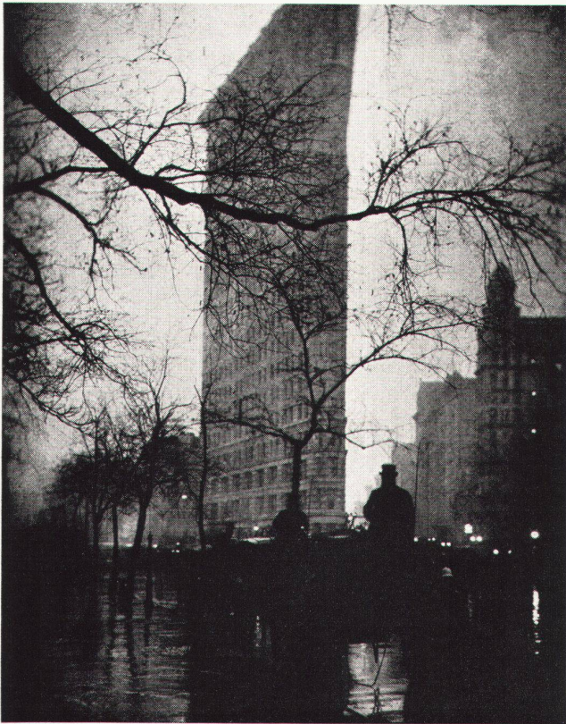
Flariton-Gebäude in New York, 1905. Photographie von Edvard Steichen
