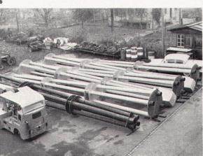
Die Ablenkpunkte, die auf dem Haupttragkabel reiten, mußten gemäß der Geometrie des Hängewerkes einzeln angefertigt werden. Dort werden gemäß der mit der Entfernung vom Pylon abnehmenden Kräfte einzelne Stränge des Hauptkabels abgekröpft und die Dreiergruppe der Hängeseile aufgenommen, deren Verzweigungswinkel mit der Entfernung vom Pylon zunimmt.
