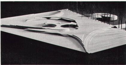
1 Dach aus vierundzwanzig Plastikschirmen Toit formé par vingt-quatre voiles en matière plastique Roof made of twenty-four plastic screens
