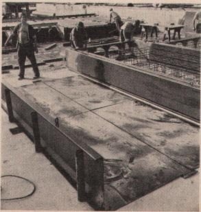
Die aus einzelnen Elementen aufgebaute Sichtbetondecke
