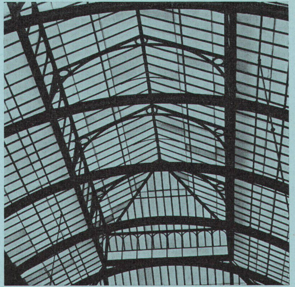
Gußeisenkonstruktion des Covent Garden Flower Market in London
