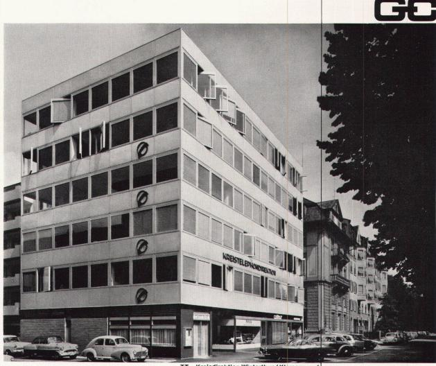
TT – Kreisdirektion Winterthur / Klemenz und Flubacher, Architekten, Zürich / Wendeflügelfenster 360° drehbar, mit Verbundverglasung und angebauten Lamellenstoren / Storen der Witterung entsprechend nach aussen oder innen drehbar / Fenster in beiden Stellungen vollständig dicht schliessend / gute Reinigungsmöglichkeiten / massive Betonbrüstung mit Peralumanblechen verkleidet.
