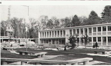
fabrication au chantier – système forain – est une méthode de transition entre la préfabrication lourde finie en usine et la construction traditionnelle.
