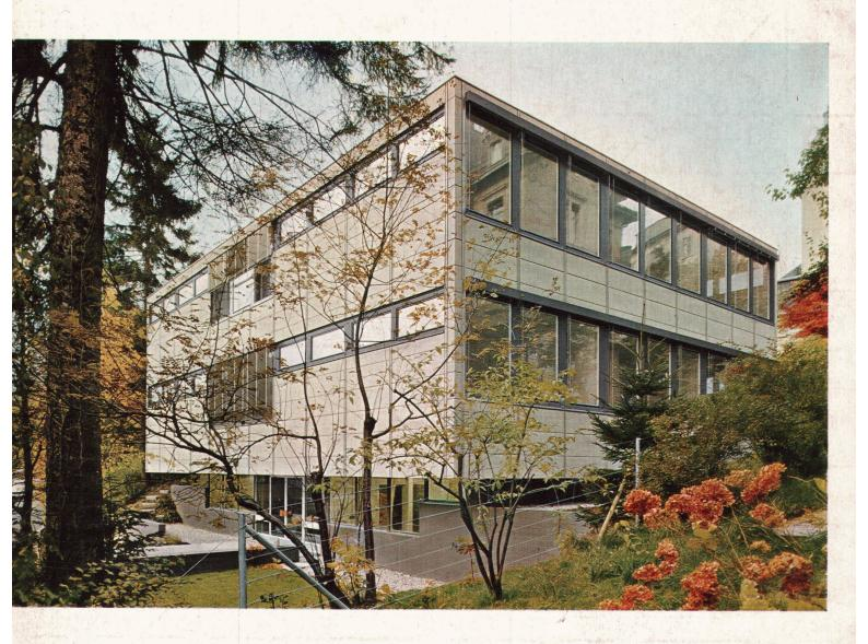
Wo die Wirtschaftlichkeit für die Erstellung von Zweckbauten im Vordergrund steht, bietet die Anwendung der vorfabrizierten Durisol-Platten für Wand- und Dachkonstruktionen entscheidende Vorteile.
