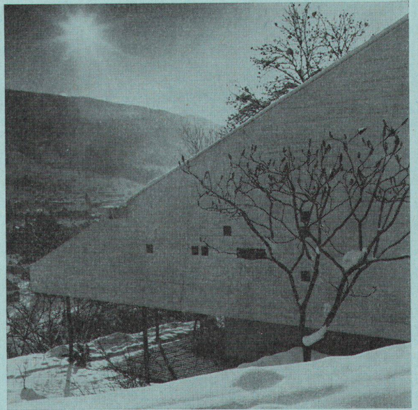
Atelierhaus eines Bildhauers in Kriens. Architekt: Walter Rüssli, Luzern
