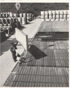
rung der tragenden Konstruktionen von besonderer Bedeutung. Die einzelnen Elemente aus Leca-Beton haben, je nach Verwendungszweck, eine Druckfestigkeit von 25 bis 150 kg/cm². Durch Zusatz von sandigem Feinkorn kann die Druckfestigkeit der Bauteile, allerdings auf Kosten des Gewichtes und der Isolation, noch erhöht werden, falls dies gewünscht wird.
