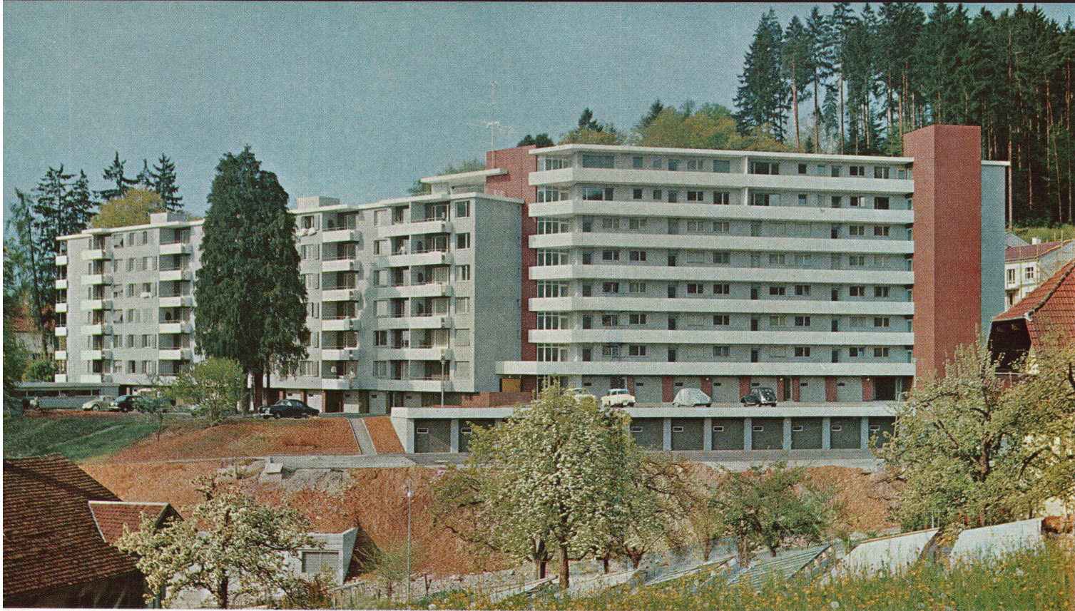
Überbauung Tannengut, Aarau ausgeführt in Durisol-Mauerwerk
