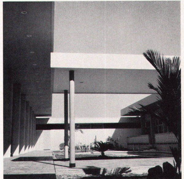
4 Innenhof der Kanzleien, Teiche für Luftkonditionierung; im Hintergrund Abwartwohnung Cour intérieure de la chancellerie, pièces d'eau pour le conditionnement de l'air; au fond, l'appartement du gardien Chancery patio, ponds for air conditioning; caretaker's lodgings in the background
