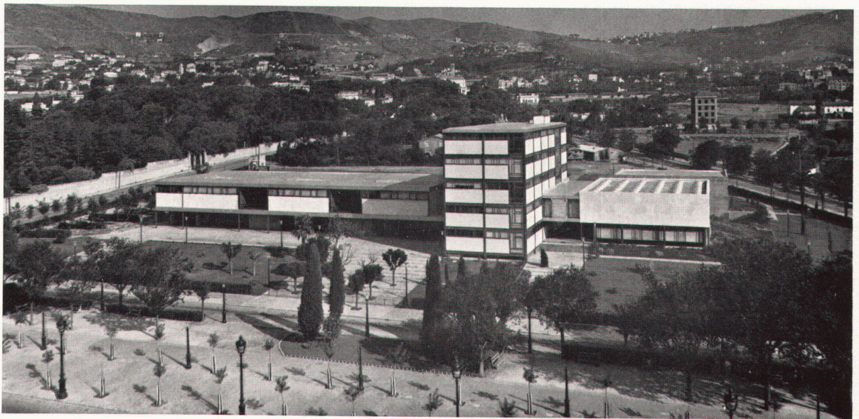
1 Gesamtansicht Vue générale Assembly view
