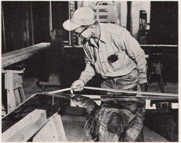
Neoprene-Dichtung mit vorgeformten Ecken und U-förmigem Querschnitt lässt sich auf der Baustelle rasch anbringen.
