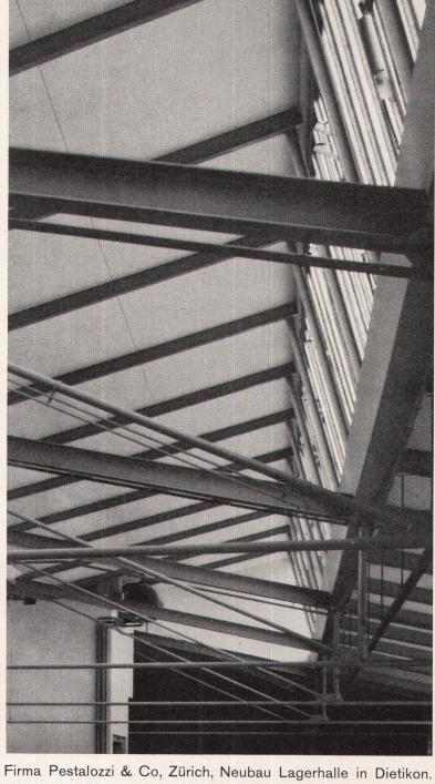
Eine vorzügliche Dach-Isolation ist mit Inaltex-Mineralwollplatten gewährleistet. Die Dachuntersichtsverkleidung mit gefasten Rigips-Platten wirkt in ästhetischer Hinsicht besonders angenehm.
