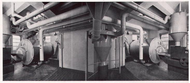
2 automatische «Bäcker»-Prisma-Dreizugkessel mit einer Leistung von je 800 000 kcal/h. Vertreten durch: F. Güdel, Basel 2 automatische Unterschubfeuerungen der Charfeu S. A., Neuchâtel
