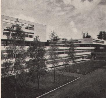
HORIZONTALE SCHIEBEFENSTER • VERSTELLBARE SONNEN-SCHUTZLAMELLEN • PLATTEN FÜR ZENT-FRENGER-HEIZUNG MIT SCHALLSCHLUCK KOMBINIERT • VERGLASUNGEN IM ERDGESCHOSS UND EINGANGSTÜREN • BRÜSTUNGSVER-KLEIDUNGEN BEI DEN DACHPARTIEN • FUSSOCKELPROFILE UND GARDEROBENTEILE • U.A.M. AUS ALUMINIUM
