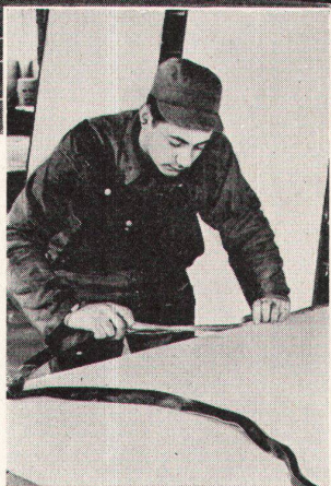
Wetterfester Anstrich aus «Hypalon» auf Beton ermöglicht farbige Aussengestaltung. . . dauernden Schutz gegen Sonne, Wettereinflüsse und Ozonwirkung.
