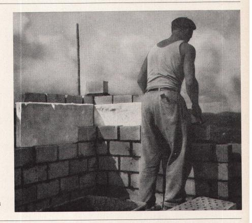
Ausführung eines doppelschaligen Fassadenmauerwerkes; Hohlraum mit SILLAN-Filz ausgefüllt
