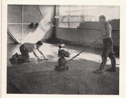
aufgebaut auf einer Emulsion von Asphalt und Wasser. Prädestiniert für Lager- und Werkhallen, Fabrikationsräume, Speditionslokale, Verladerampen, Perronanlagen usw.
