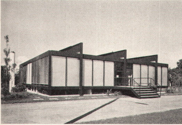
4 Kleines Geschäftshaus in Genf-Cointrin. Architekten: Pierre Bussat BSA und Jean-Marc Lamunière BSA, Genf
