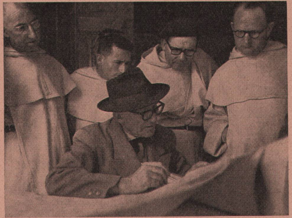
Le Corbusier bespricht mit Dominikanermönchen die Bauarbeiten des Klosters La Tourette Photo: René Buri
